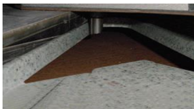
(3) Вырезание с помощью фрезы и направляющей
