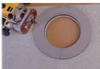
(2) Вырезание поврежденного участка с 1" (25 мм) шаблонной направляющей и 3/8" (9,5 мм) или 1/2" (12 мм) фрезы
